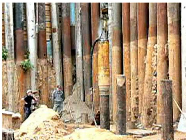
Рис. 1. Возведение подпорных стен при строительстве открытым способом станций метро в Казани при помощи пневматического молота Тайфун-500
