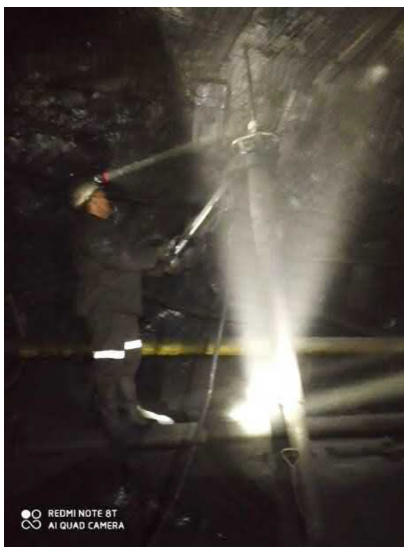
Рис. 6. Промышленные испытания пневмоударника АШ 43 на станке СБР
