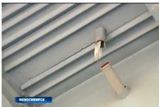
Рис. 4. Место отлома и упавшая деталь конструкции моста (2017 г)
