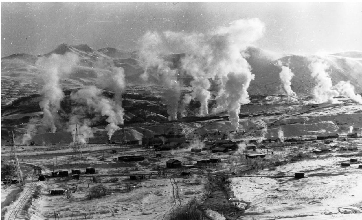
**Рис. 1.2.** Паужетское геотермальное месторождение. Пробные выпуски пара из разведочных скважин. Фото из архива В.М. Сугрובה.
