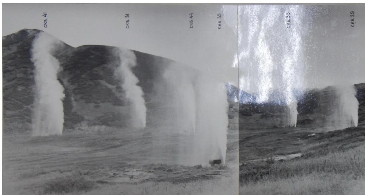
**Рис.1.5.** Выпуск пароводяной смеси из скважин восточного участка Больше-Банного месторождения [фото из отчета Евтухова А.Д., 1970]
