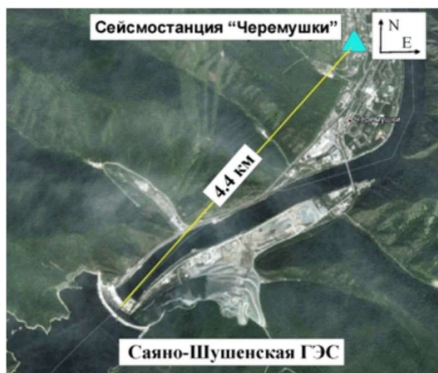
Сейсмометрическая система в плотине Саяно-Шушенской ГЭС
