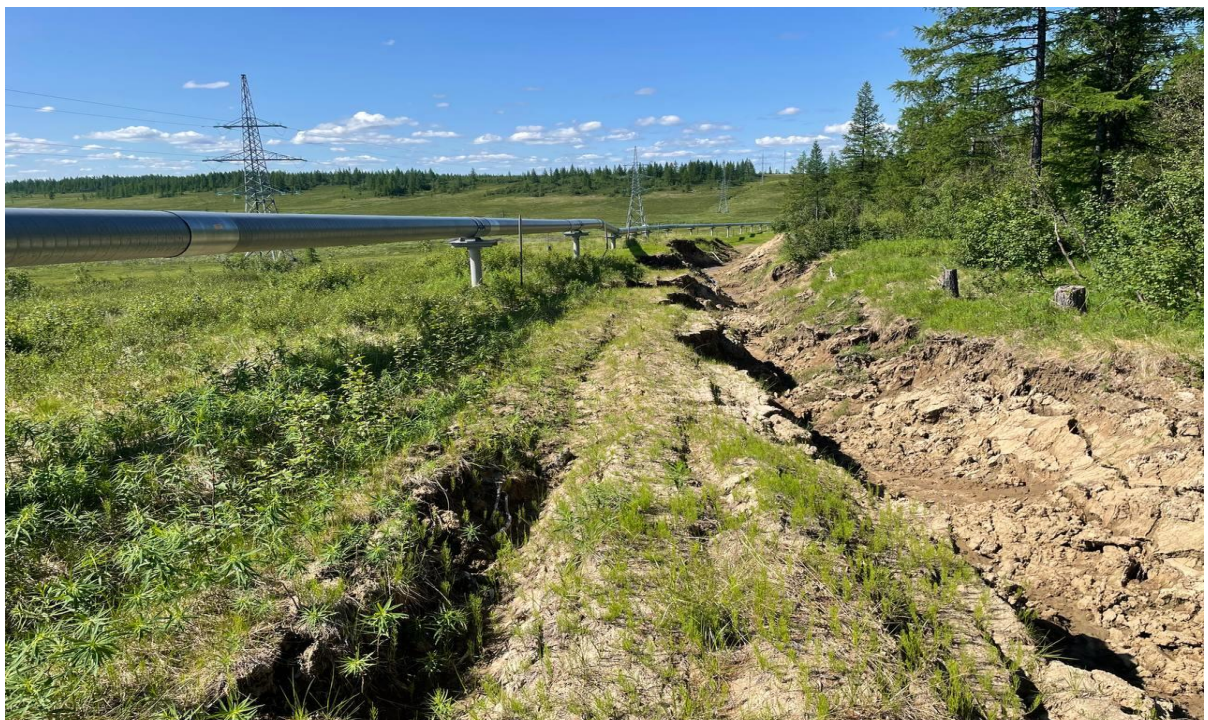
Рисунок 9. Проявление термоэрозии вдоль сооружения.
